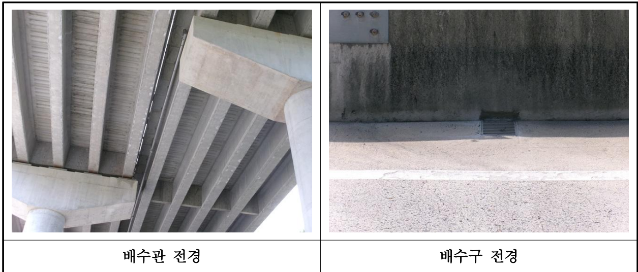
【사진 27.3.22】 배수시설 전경
