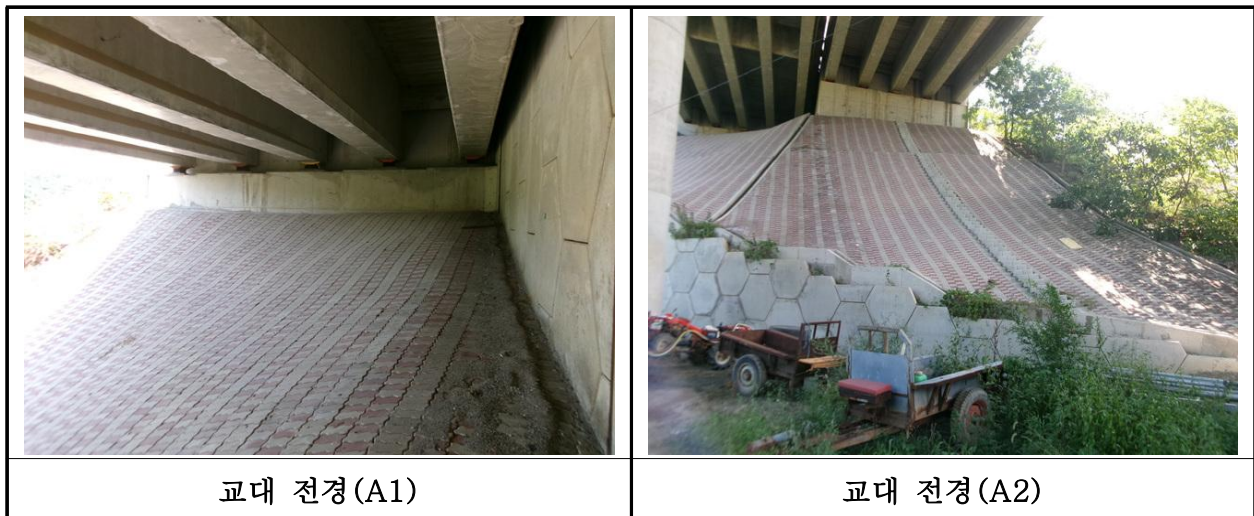
【사진 27.3.35】 교대 전경
