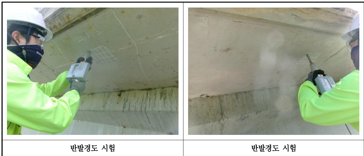
【사진 27.4.2】 반발경도시험 현장사진
