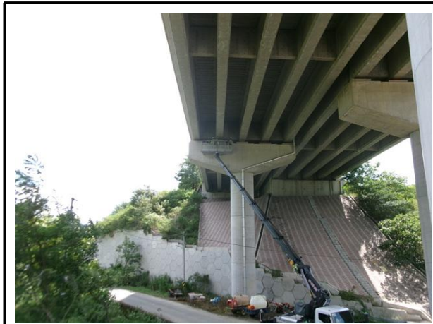
부재 현장측정 전경
