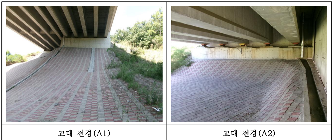
【사진 27.3.8】 교대 전경
