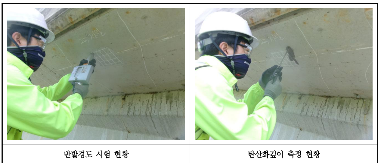
【사진 27.4.1】 콘크리트 내구성조사 현황
