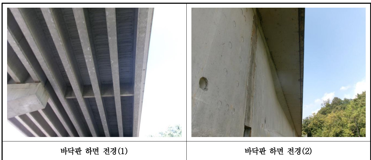
【사진 27.3.2】 바닥판하면 전경
