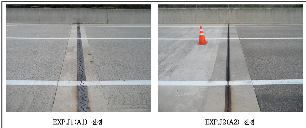
【사진 27.3.44】 신축이음장치 전경
