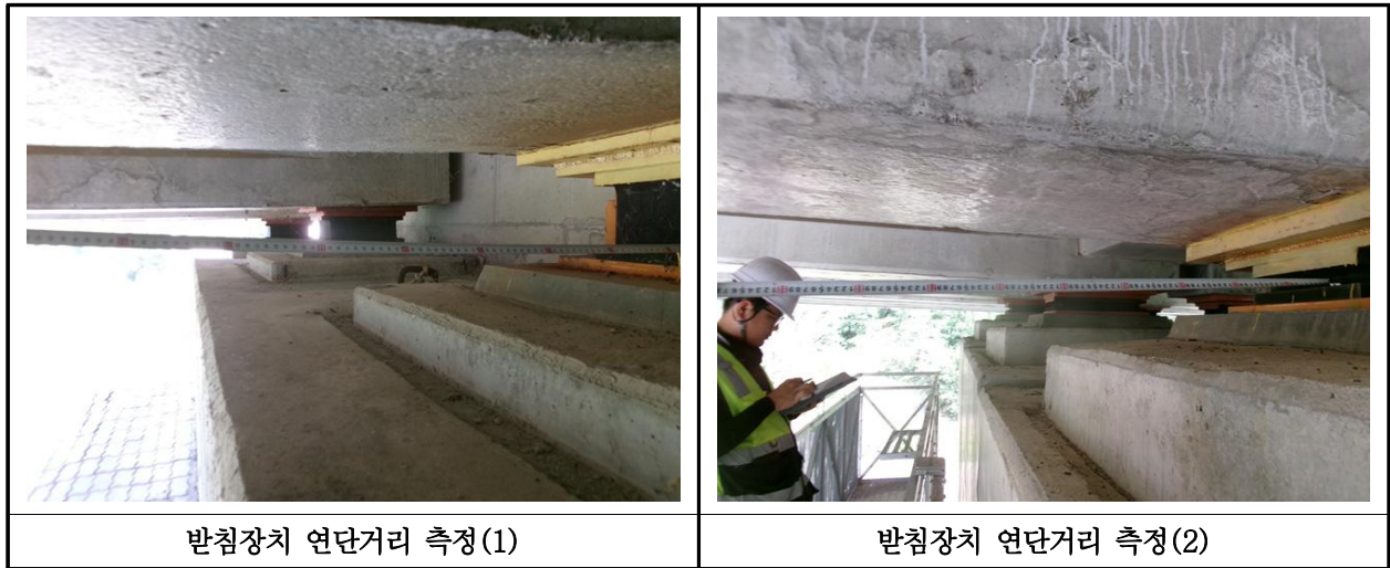
【사진 27.3.42】 교량받침장치 연단거리측정
