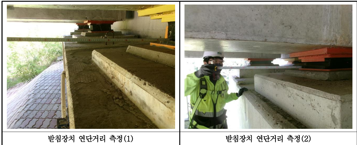
【사진 27.3.15】 교량받침장치 연단거리측정
