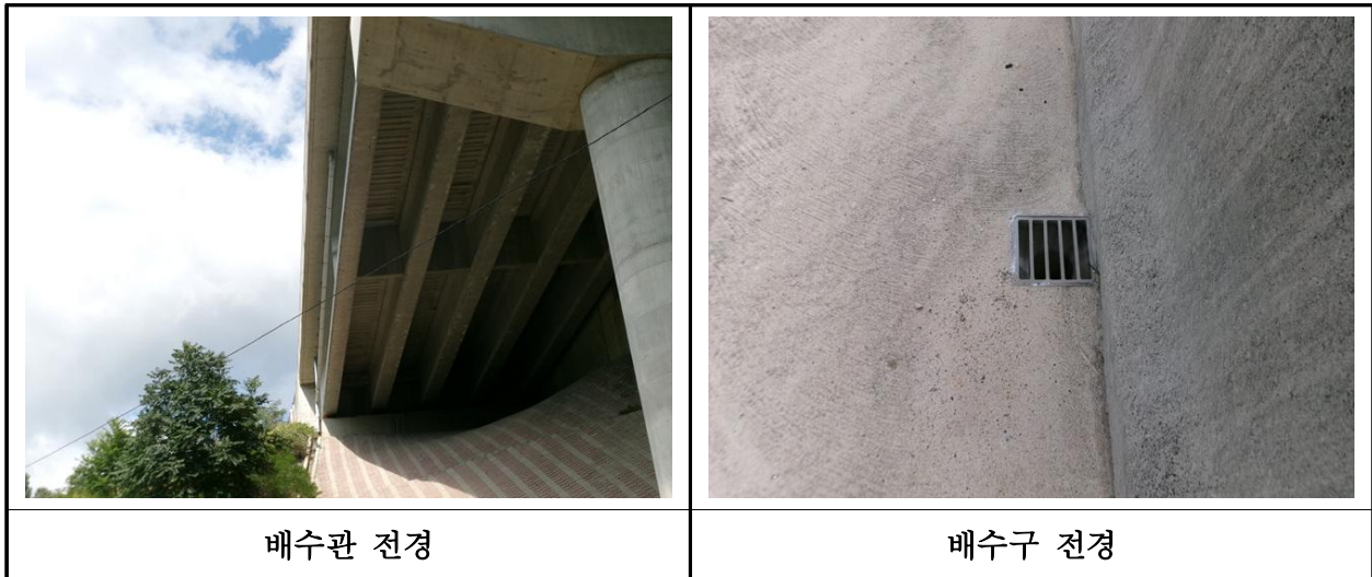
【사진 27.3.49】 배수시설 전경
