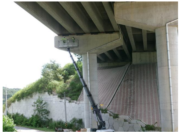
부재 현장측정 전경
