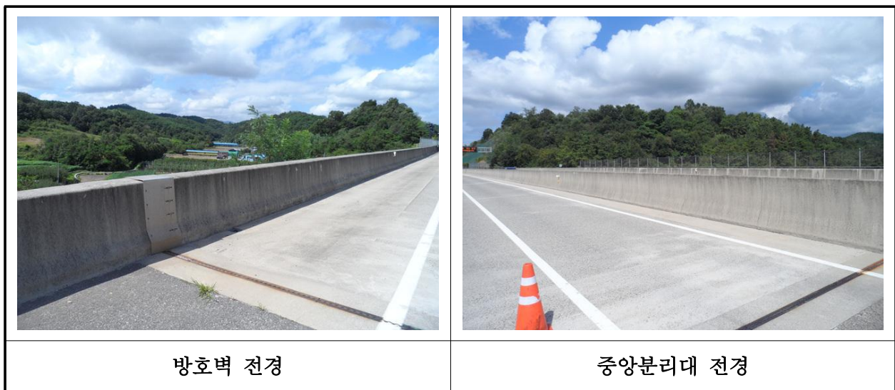
【사진 27.3.51】 방호벽 및 중앙분리대 전경
