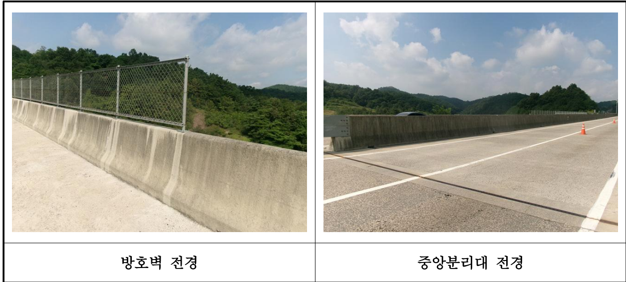
【사진 27.3.24】 방호벽 및 중양분리대 전경
